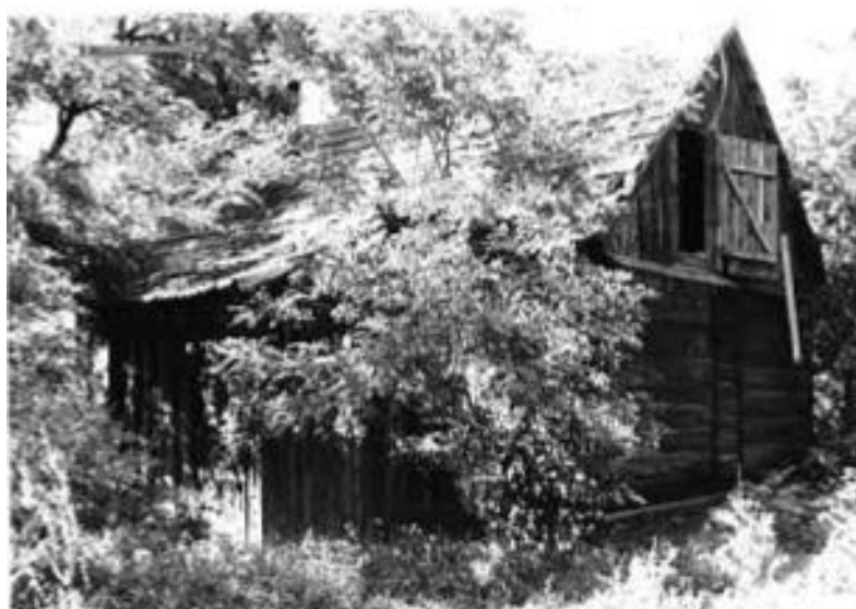
Nowa Wola dom nr 14 - zamieszczony w dokumentacji WKZ
