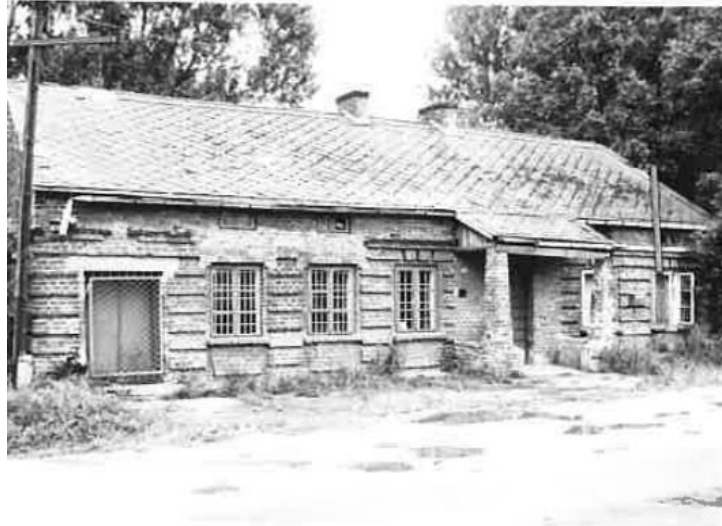
Dąbrowa Rusiecka dom nr 12 - zamieszczony w dokumentacji WKZ
